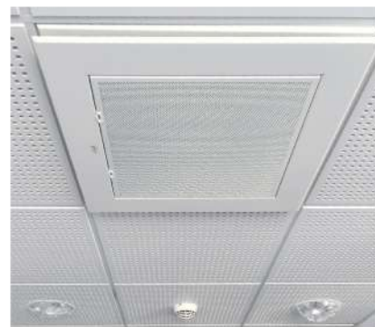
คอยล์พัดลมทั้งหมด 175 ตัวที่เชื่อมต่อกับเครื่องทำความเย็น e-series
