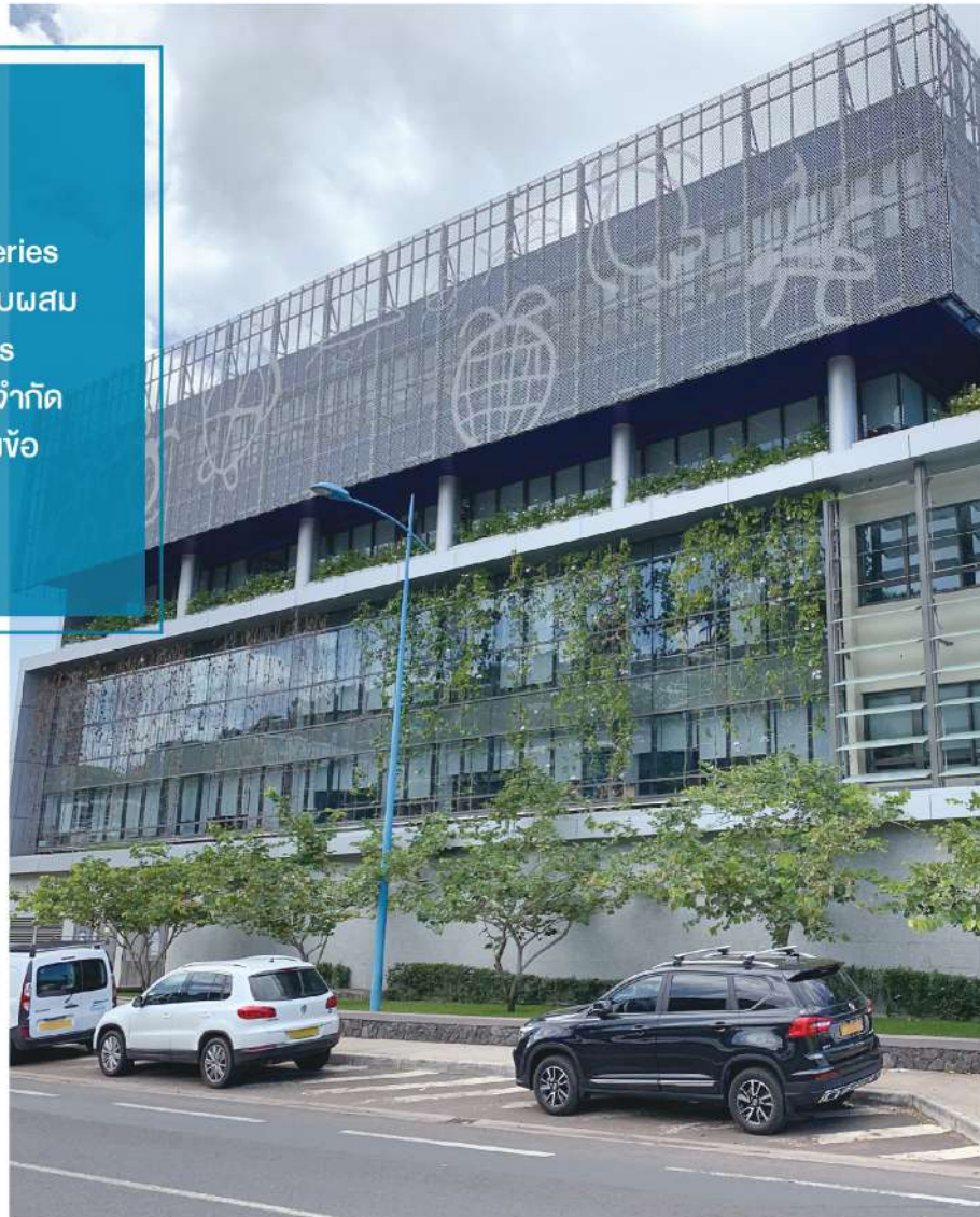
อาคารพาณิชย์ขนาด 14,000 ลูกบาศก์เมตร
