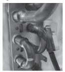
เมื่อติดตั้งเทอร์มิสเตอร์คอยล์เย็นเครื่องในบ้าน เข้ากับชิ้นส่วนที่มีรูปร่างเป็นคลิปยึด หรือชิ้น ส่วนที่มีรูปร่างเป็นที่ยึดจับ สายไฟควรชี้ลงไป
